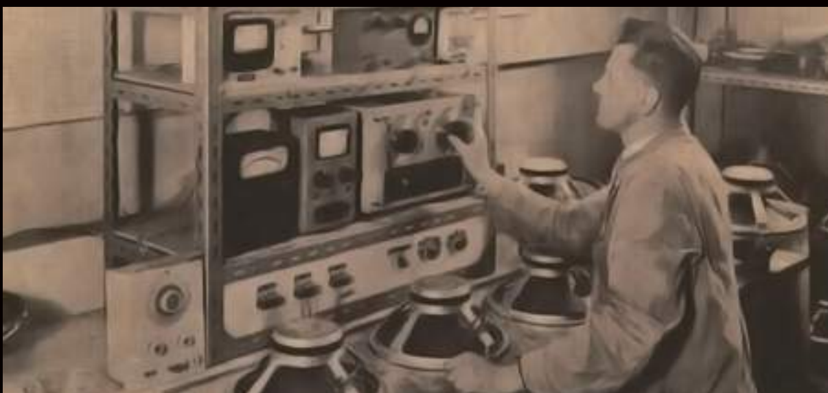
Come era allora e così è adesso, ogni altoparlante Wharfedale viene testato da esperti su tutta la sua gamma di frequenze e la risonanza dei bassi viene controllata e annotata nei registri di produzione giornalieri.
